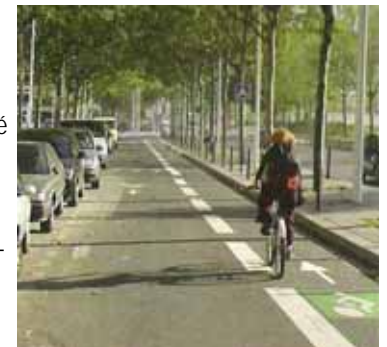
Le contresens cyclable permet aux utilisateurs d'emprunter des trajets plus directs et moins achalandés par les automobiles.
